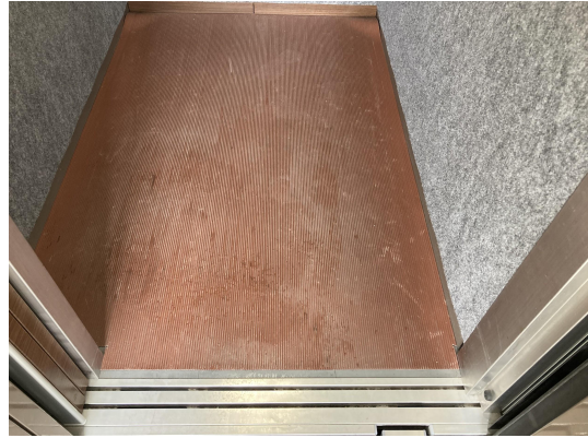
EV・ホール
