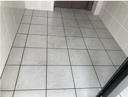
EV・ホール
