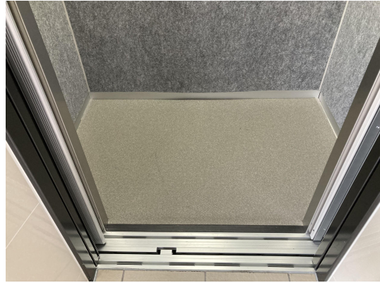
EV・ホール
