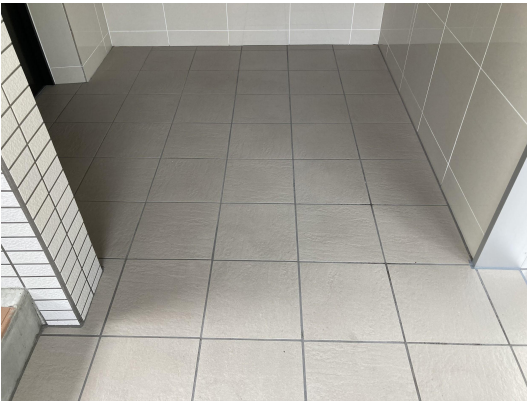
EV・ホール
