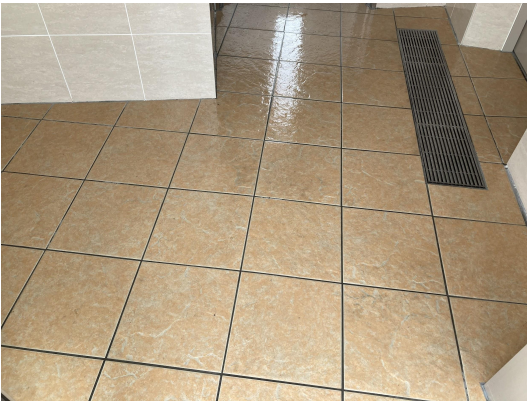
EV・ホール
