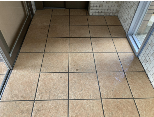
EV・ホール
