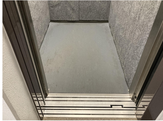
EV・ホール
