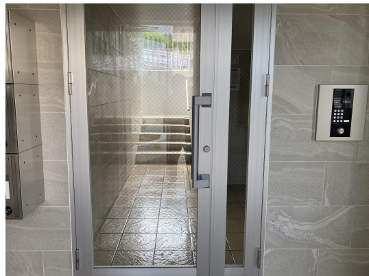
エントランスガラス
