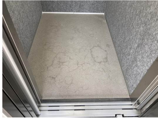
EV・ホール
