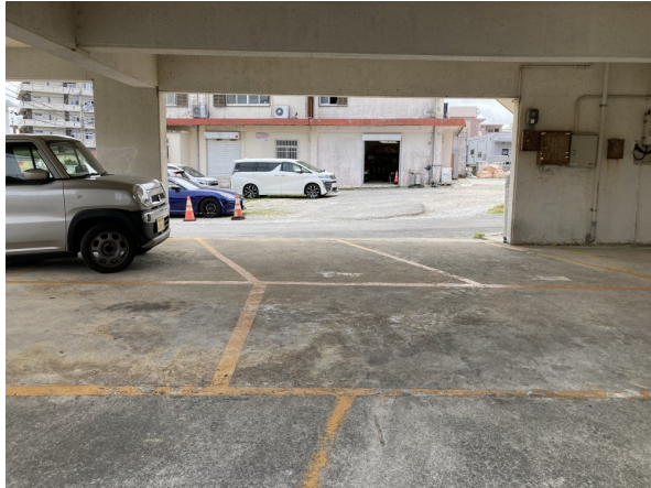
1. 駐車場・駐輪場
