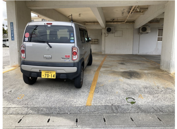
1. 駐車場・駐輪場
