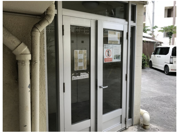
5.エントランスホール（タイル・ガラス）
