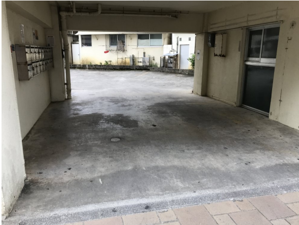
1. 駐車場・駐輪場
