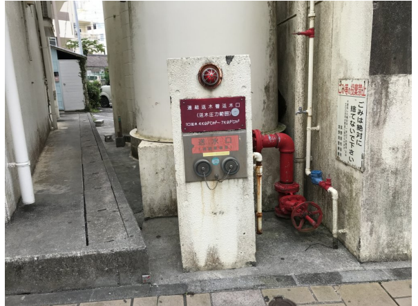
2. 受水槽フェンスまわり
