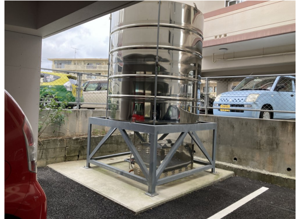
2. 受水槽フェンスまわり
