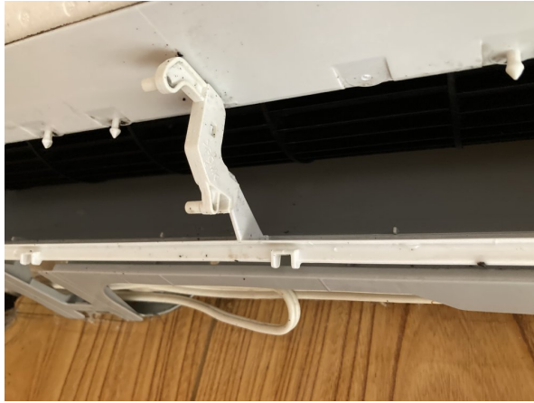
12.エアコンクリーニング
