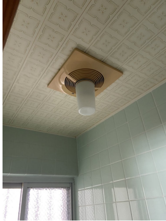
換気扇(照明付)取替前
