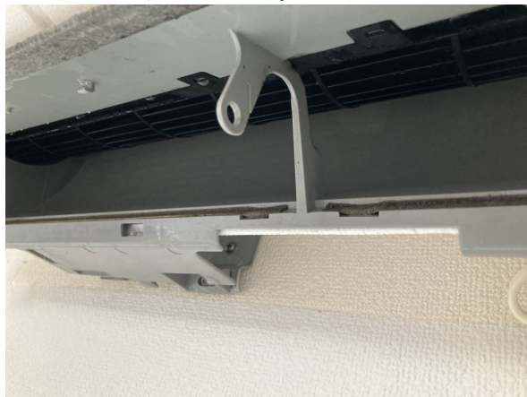
14.エアコンクリーニング
