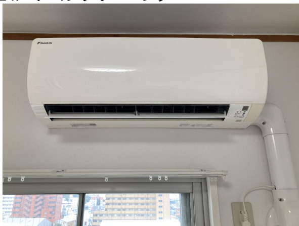
14.エアコンクリーニング
