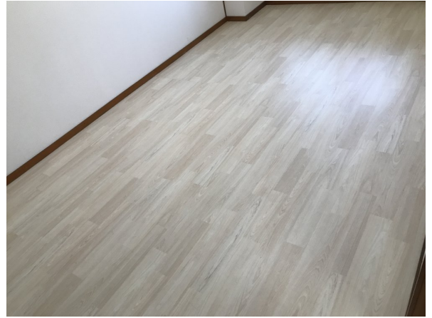
14.床剥離洗浄after
