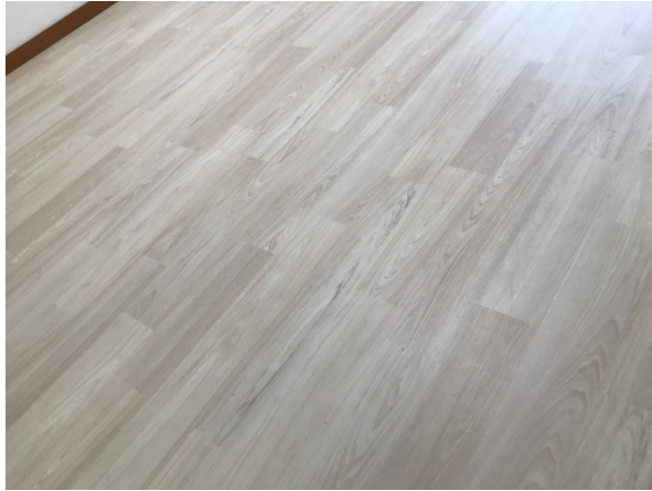
14.床剥離洗浄after
