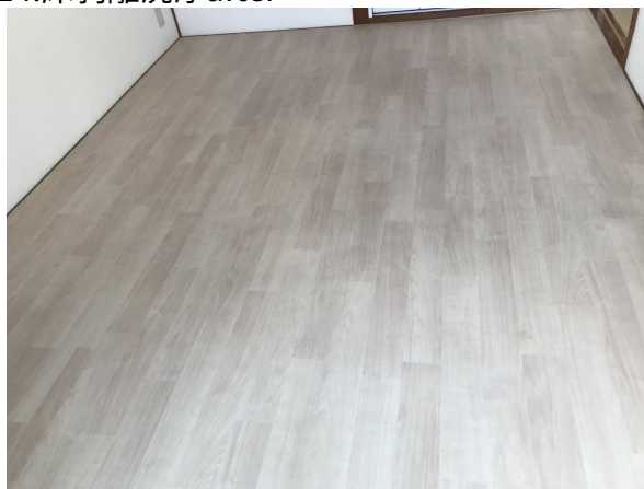
14.床剥離洗浄after
