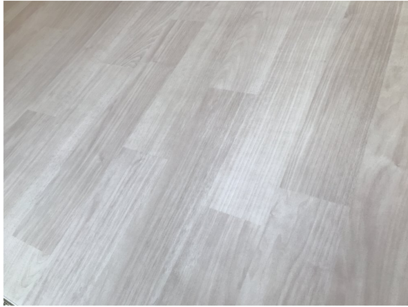
14.床剥離洗浄after
