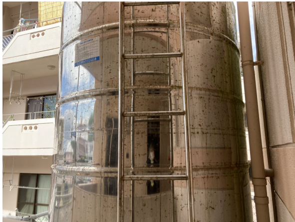
2. 受水槽フェンスまわり
