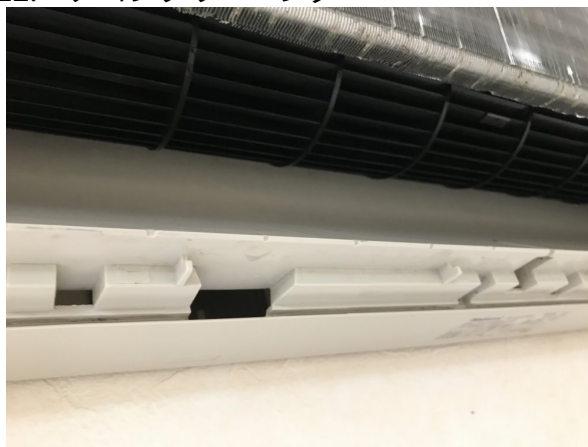
12.エアコンクリーニング
