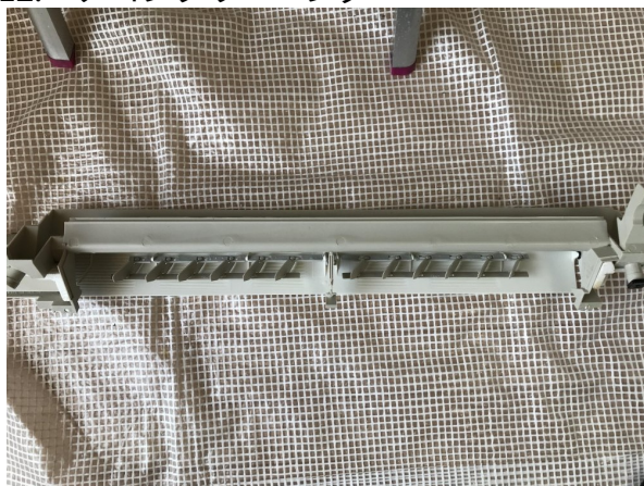
12.エアコンクリーニング
