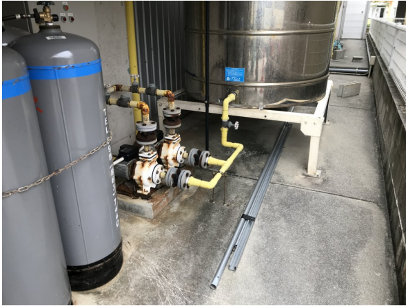
2. 受水槽フェンスまわり
