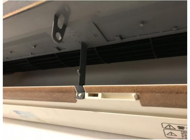
1.エアコンクリーニング
