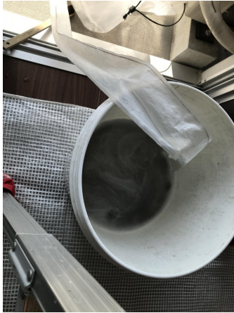
1.エアコンクリーニング
