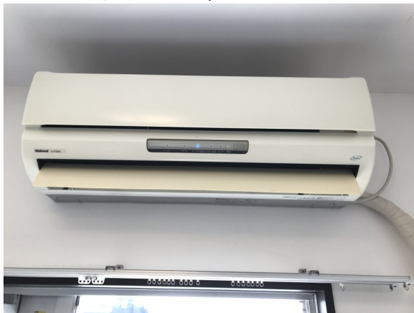
1.エアコンクリーニング
