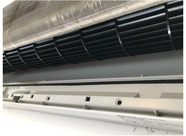
1.エアコンクリーニング
