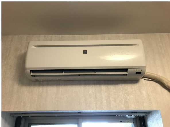
1.エアコンクリーニング
