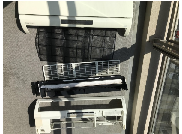
1.エアコンクリーニング
