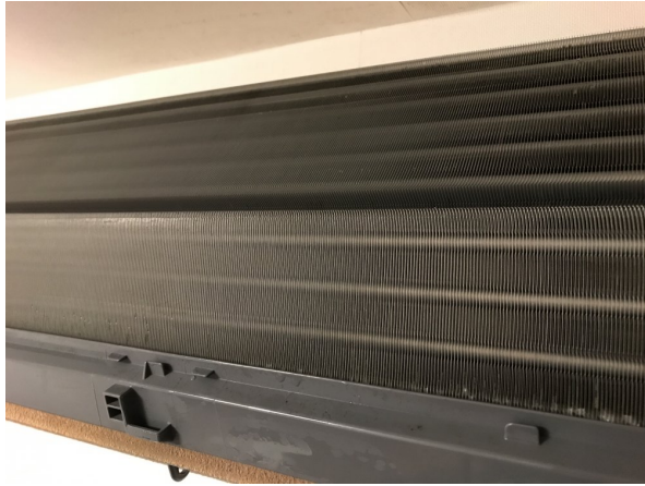
1.エアコンクリーニング
