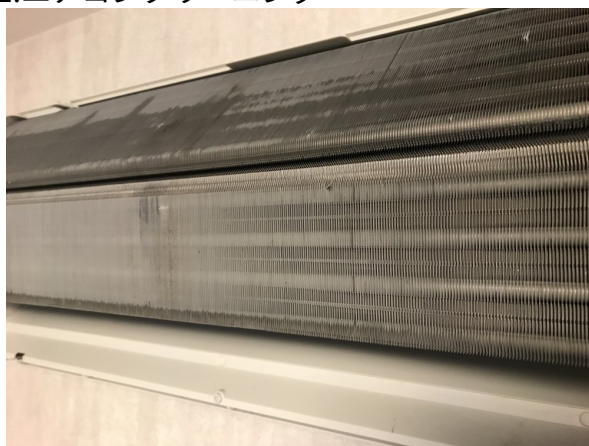
1.エアコンクリーニング
