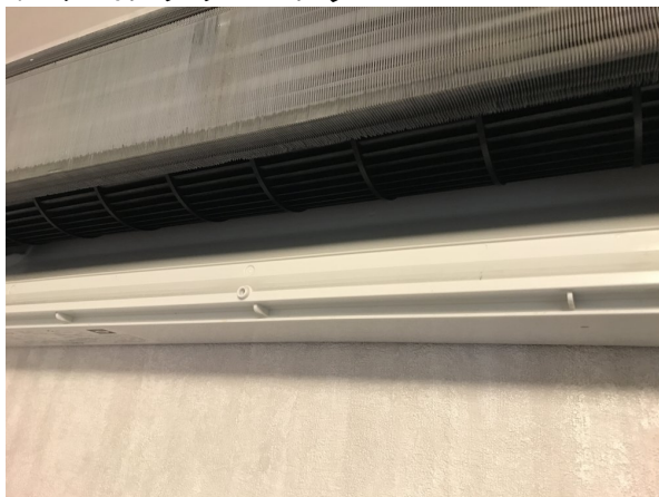
1.エアコンクリーニング
