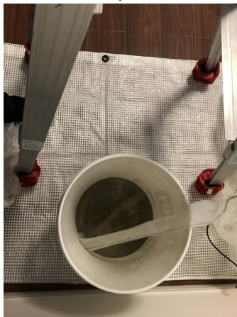
1.エアコンクリーニング
