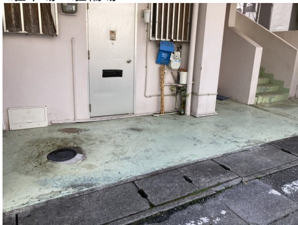
1. 駐車場・駐輪場
