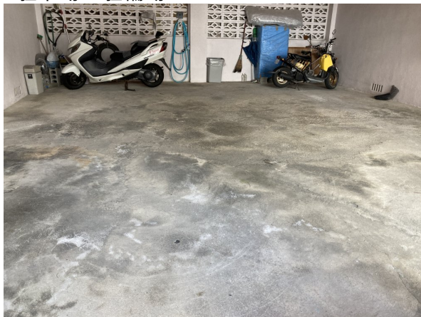
1. 駐車場・駐輪場
