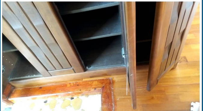
靴箱割れ有り
