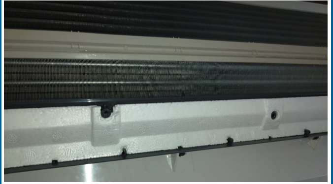
15.エアコンクリーニング
