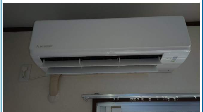
15.エアコンクリーニング
