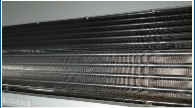
15.エアコンクリーニング
