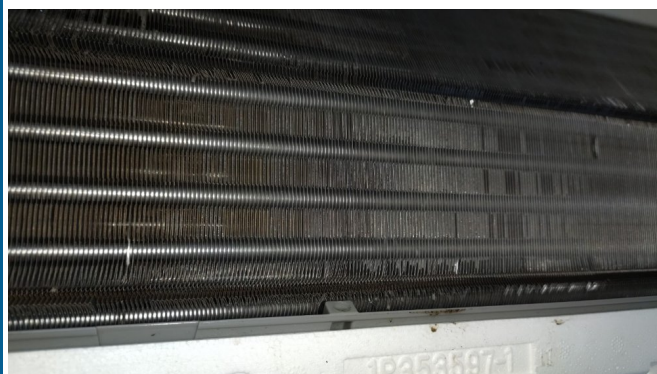
16.エアコンクリーニング
