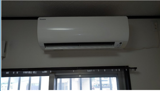
14.エアコンクリーニング
