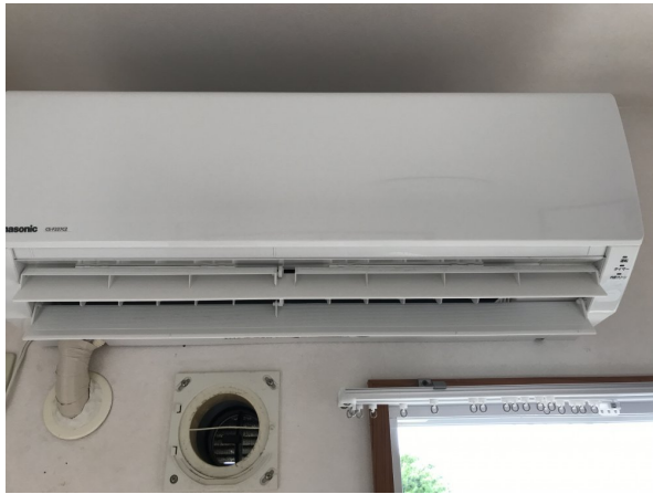
14.エアコンクリーニング
