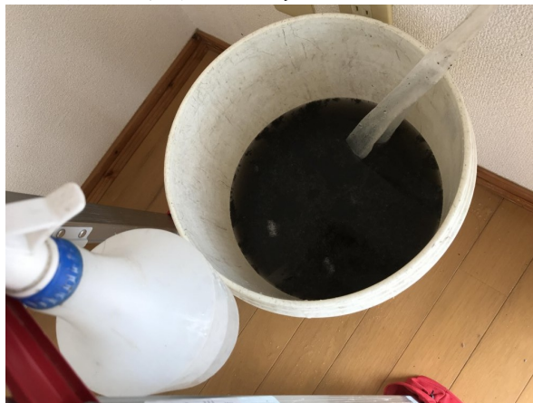
13.エアコンクリーニング
