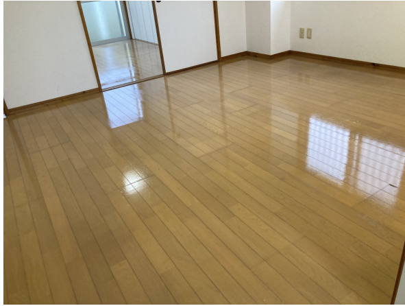
19.床剥離洗浄after
