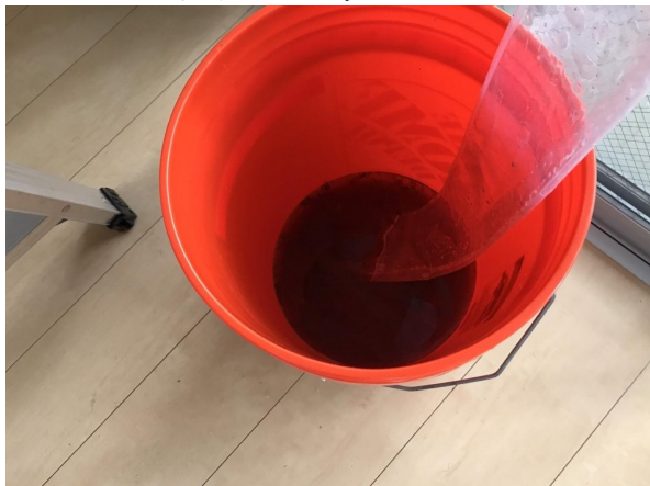
11.エアコンクリーニング
