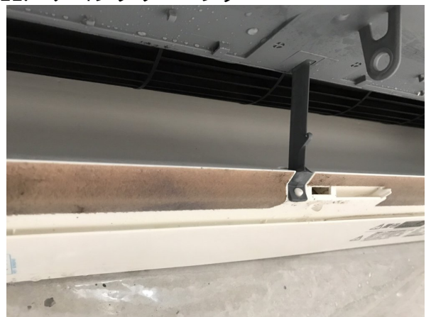
11.エアコンクリーニング
