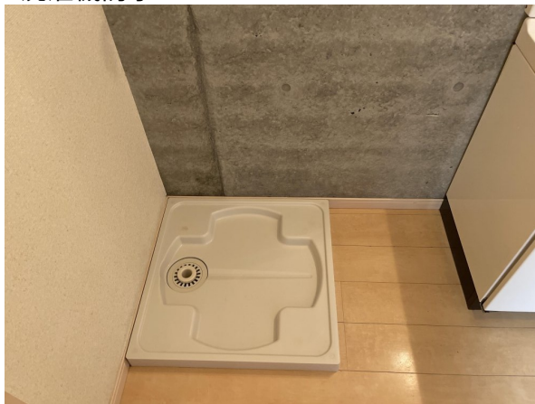
5.洗濯機防水パン
