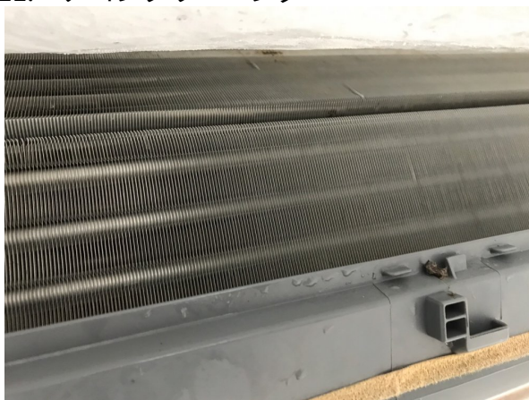
11.エアコンクリーニング
