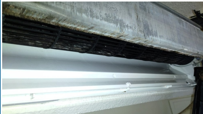
15.エアコンクリーニング
