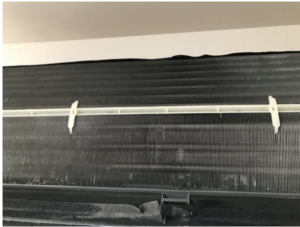
13.エアコンクリーニング
