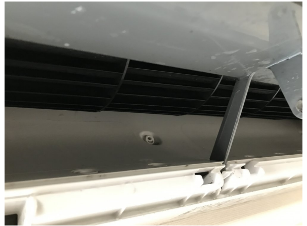
13.エアコンクリーニング
