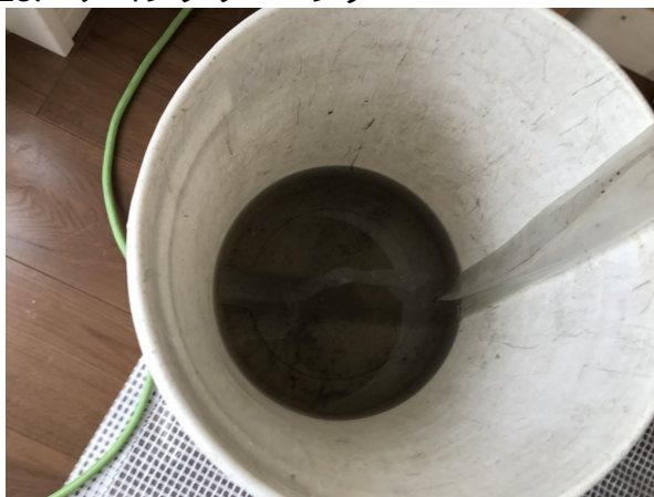
13.エアコンクリーニング
