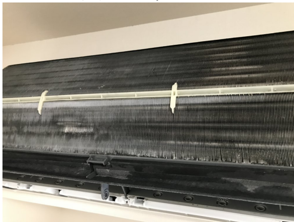
14.エアコンクリーニング
