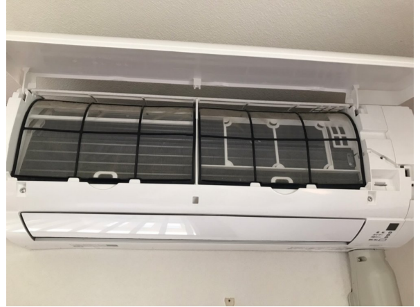
14.エアコンクリーニング
