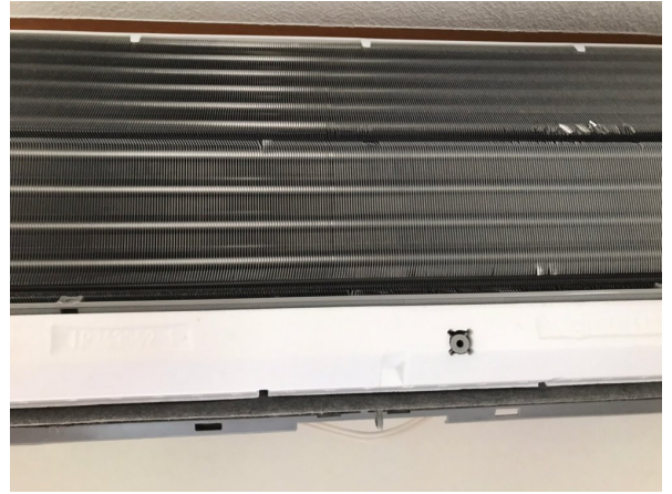
14.エアコンクリーニング
