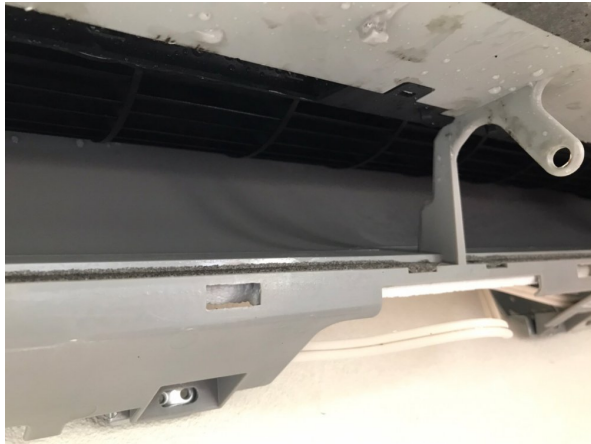
14.エアコンクリーニング
