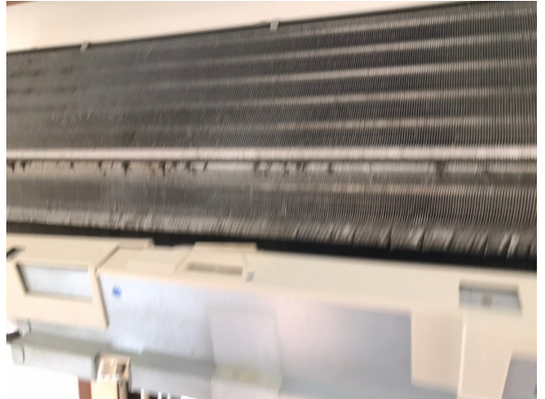
14.エアコンクリーニング
