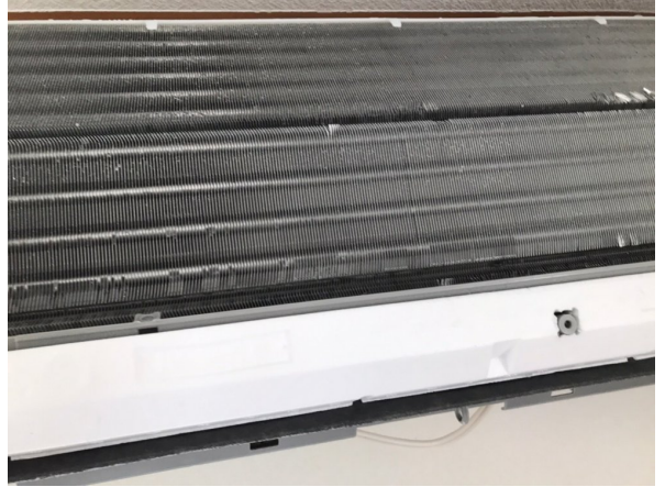
14.エアコンクリーニング
