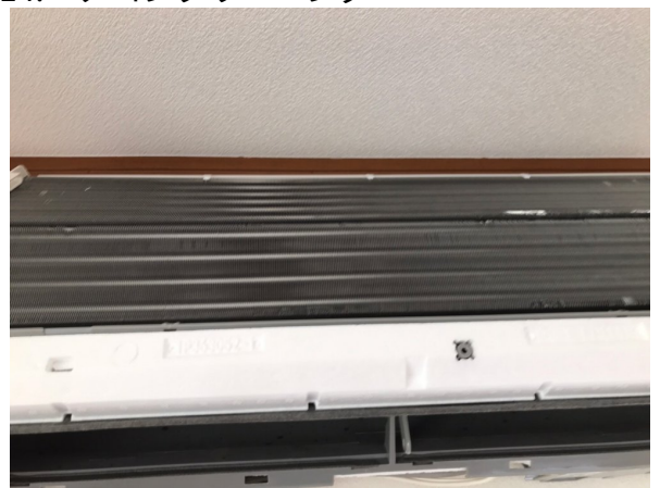
14.エアコンクリーニング
