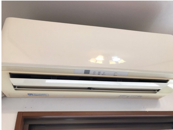
14.エアコンクリーニング
