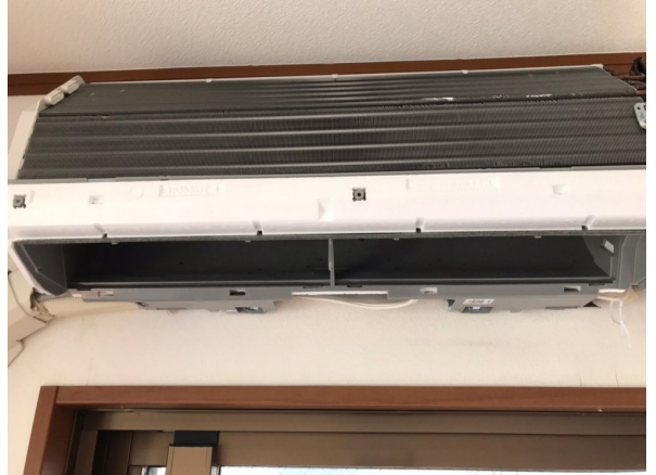
14.エアコンクリーニング
