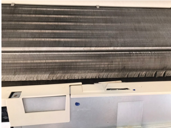
14.エアコンクリーニング
