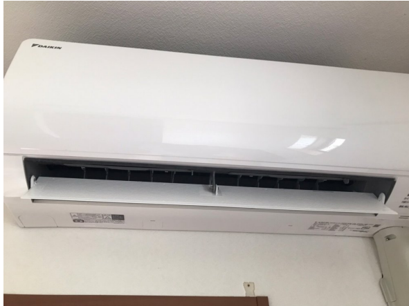
14.エアコンクリーニング
