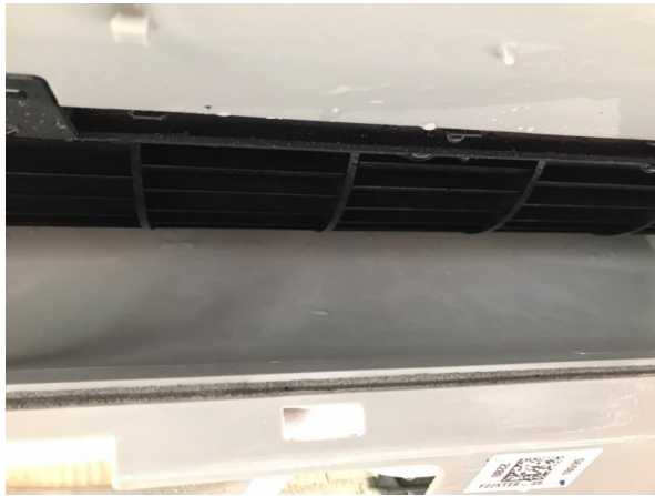
14.エアコンクリーニング
