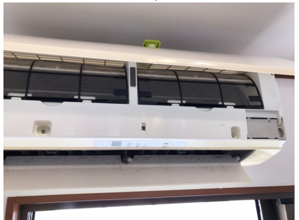
14.エアコンクリーニング
