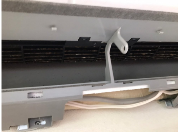
14.エアコンクリーニング
