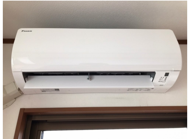
14.エアコンクリーニング
