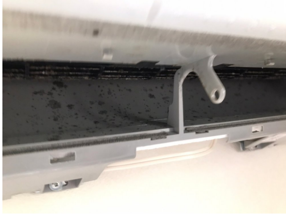
14.エアコンクリーニング
