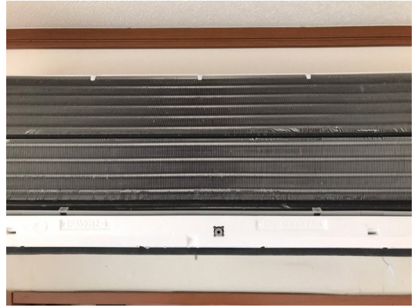
14.エアコンクリーニング
