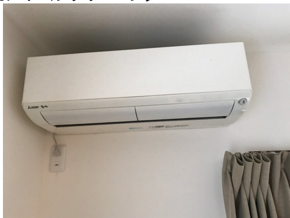
5.エアコンクリーニング
