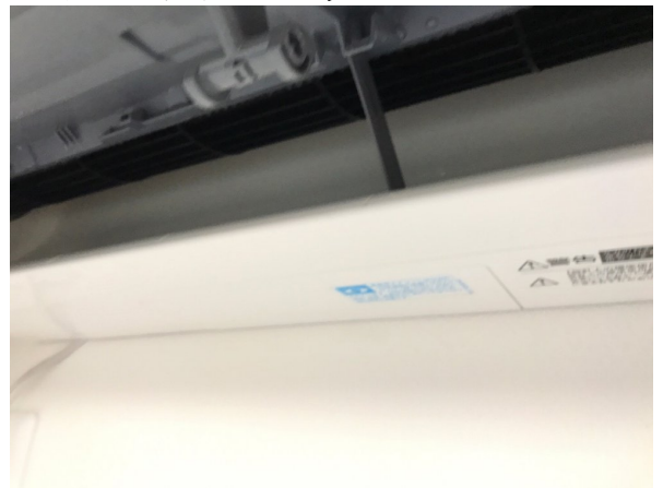
5.エアコンクリーニング
