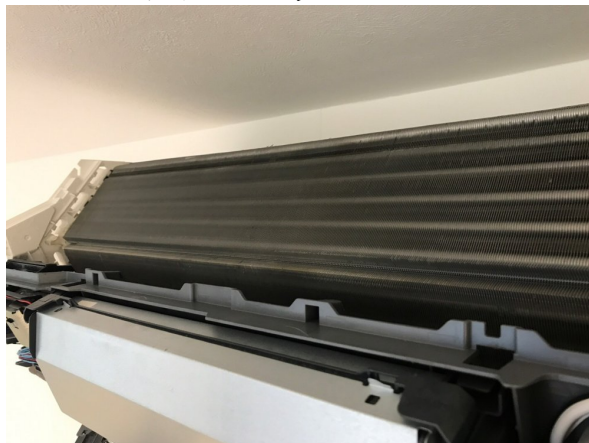
5.エアコンクリーニング
