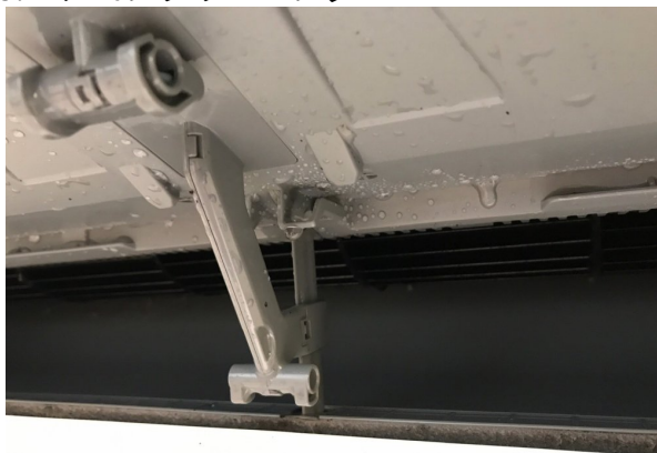
5.エアコンクリーニング
