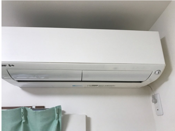
5.エアコンクリーニング
