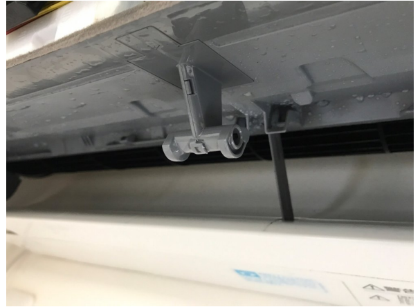
5.エアコンクリーニング
