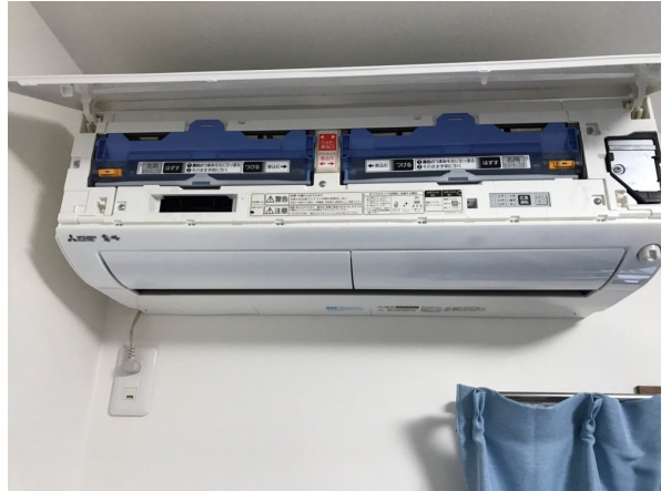
5.エアコンクリーニング
