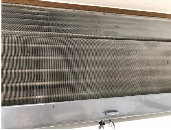
14.エアコンクリーニング
