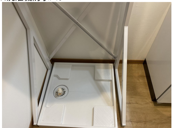
洗濯排水Lボー取付
