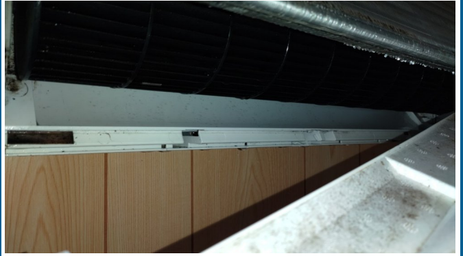
1.エアコンクリーニング
