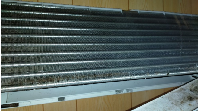
1.エアコンクリーニング
