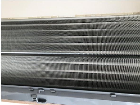
16.エアコンクリーニング
