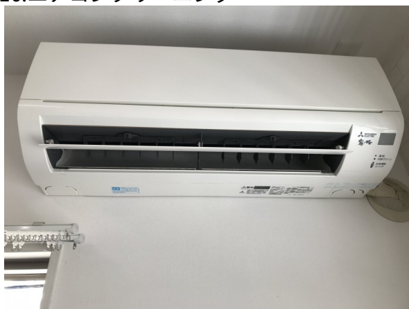
16.エアコンクリーニング
