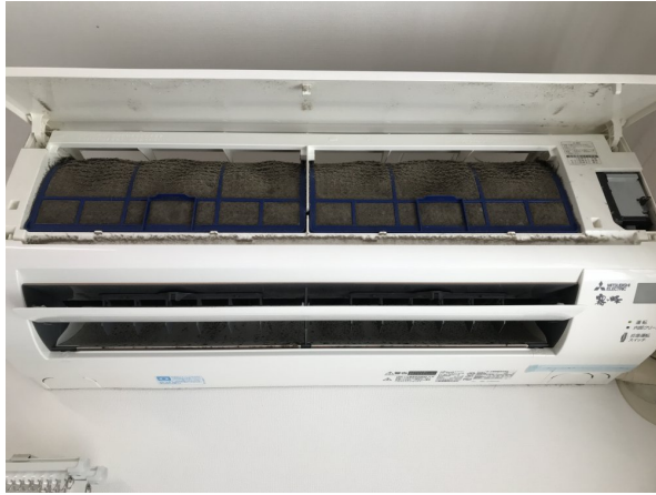
16.エアコンクリーニング
