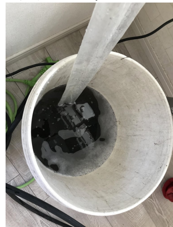
16.エアコンクリーニング
