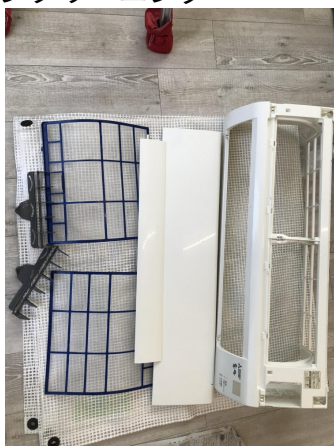
16.エアコンクリーニング
