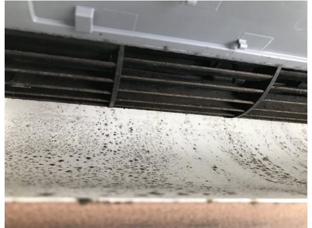
16.エアコンクリーニング
