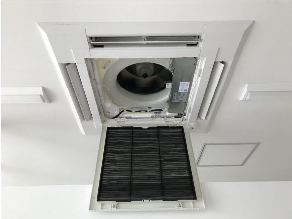
7.エアコンクリーニング
