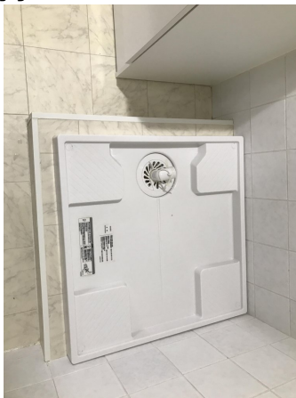
7.洗濯機防水パン
