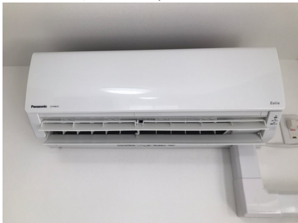
14.エアコンクリーニング
