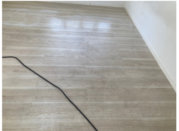
床剥離洗浄before
