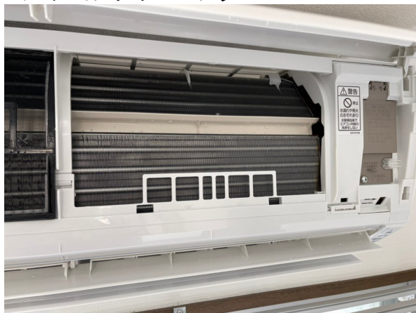
12.エアコンクリーニング
