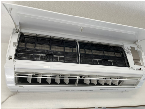
12.エアコンクリーニング
