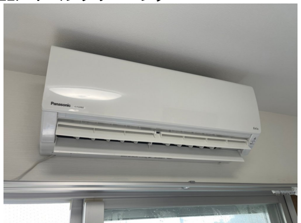
12.エアコンクリーニング
