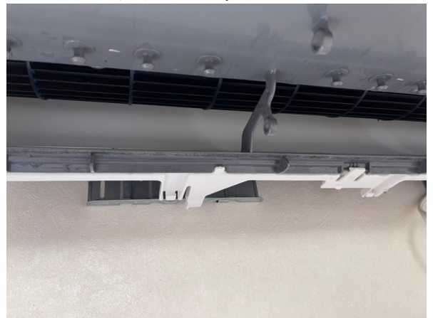
15.エアコンクリーニング
