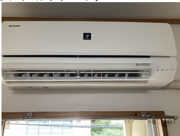
17.エアコンクリーニング
