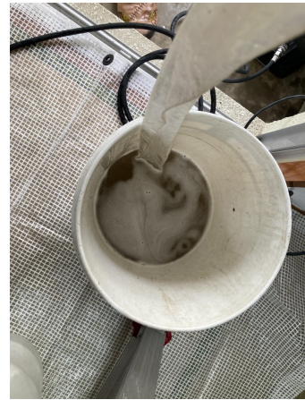
17.エアコンクリーニング
