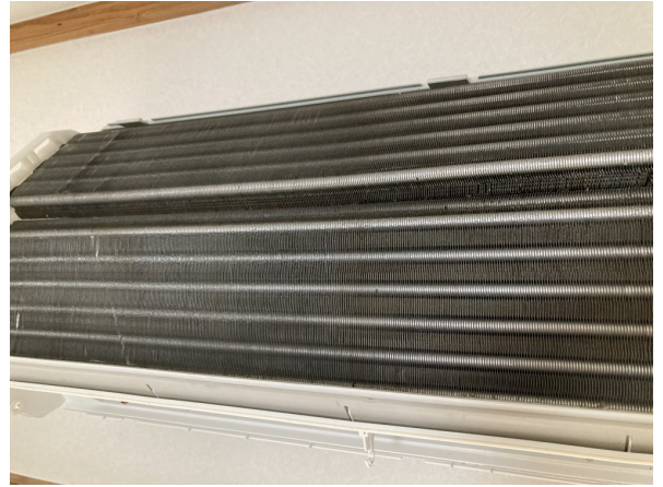
17.エアコンクリーニング
