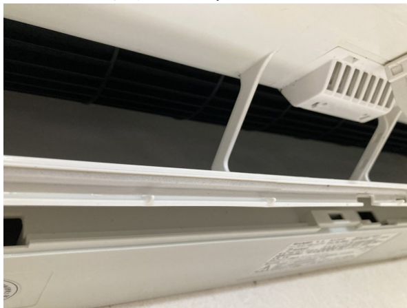
17.エアコンクリーニング
