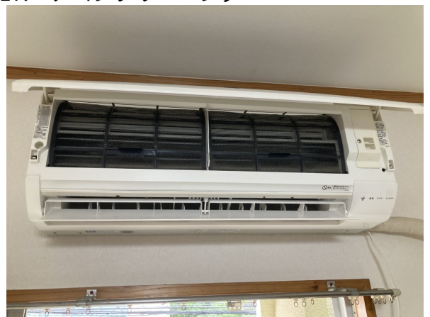
17.エアコンクリーニング
