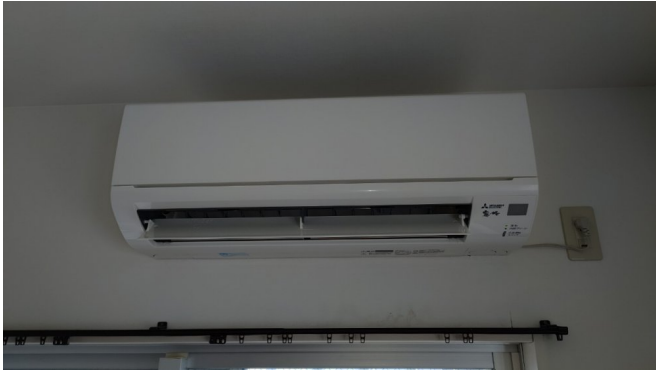
15.エアコンクリーニング
