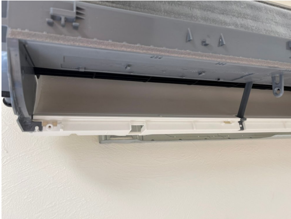
13.エアコンクリーニング
