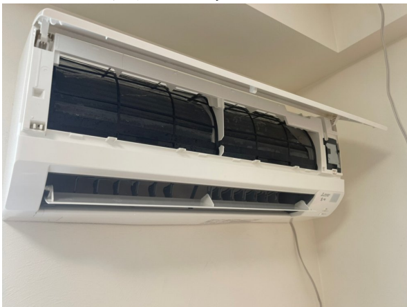
13.エアコンクリーニング
