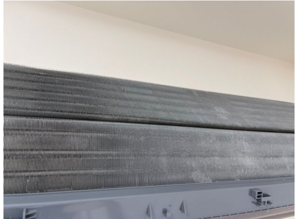
13.エアコンクリーニング
