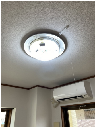
蛍光灯取替30・32W
