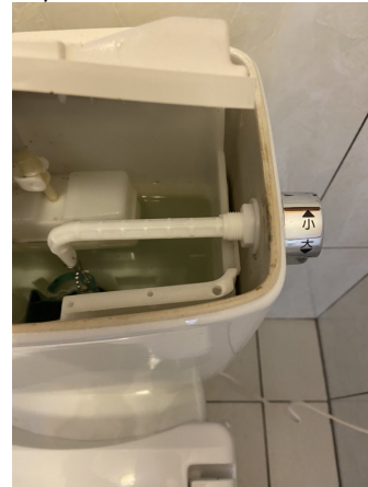
トイレタンクレバー取替
