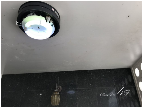
4Fの照明交換 20W丸・スターター
