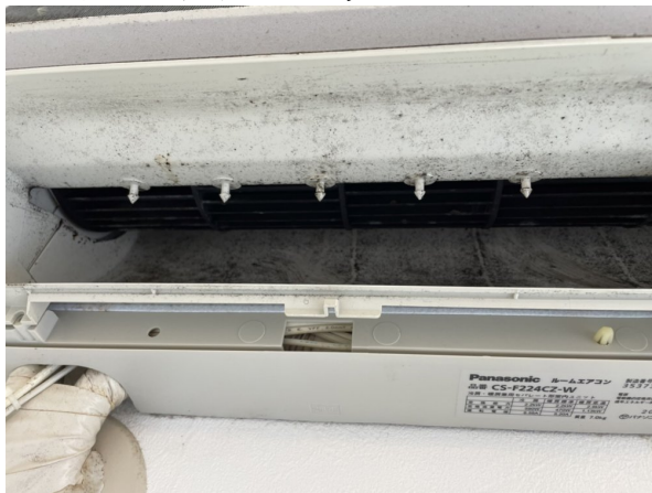
15.エアコンクリーニング
