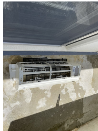
15.エアコンクリーニング
