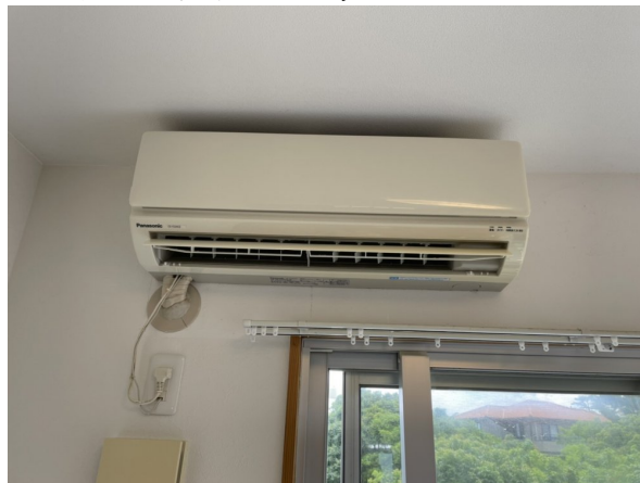
15.エアコンクリーニング
