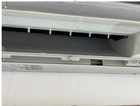
15.エアコンクリーニング
