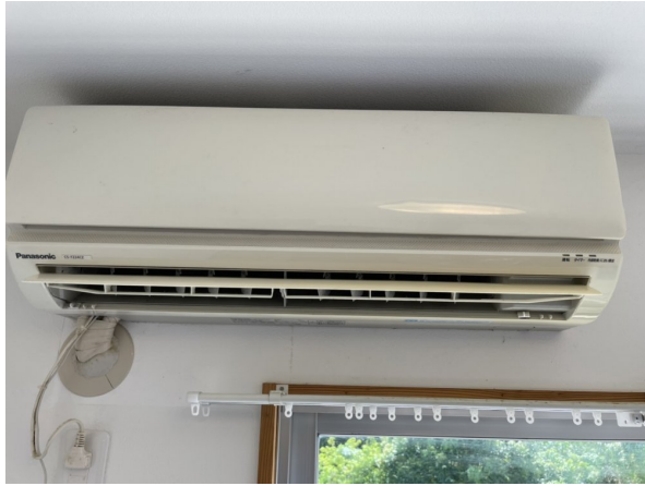
15.エアコンクリーニング
