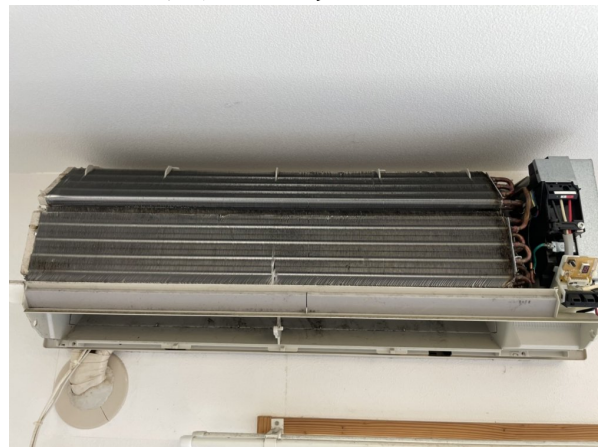
15.エアコンクリーニング
