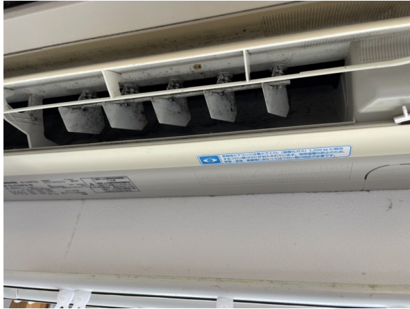
15.エアコンクリーニング
