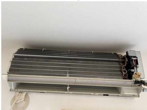
15.エアコンクリーニング
