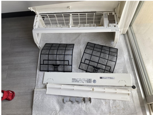
9.エアコンクリーニング
