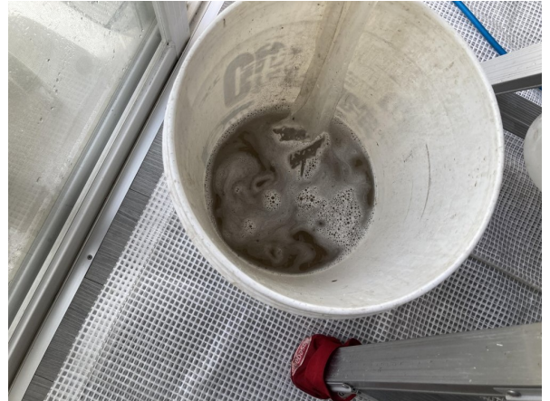
9.エアコンクリーニング
