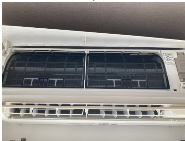
9.エアコンクリーニング
