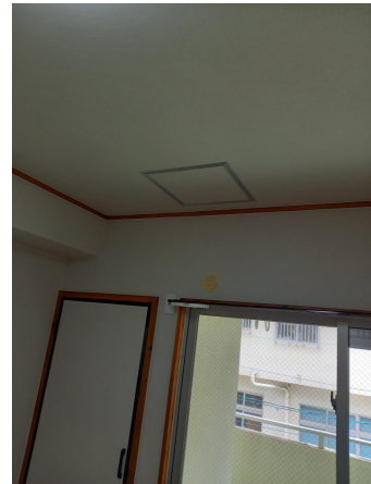
天井点検口取付済み
