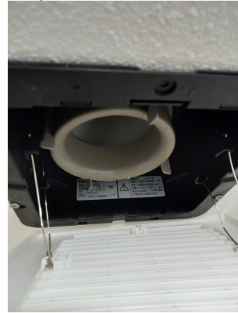
トイレ換気扇取替
