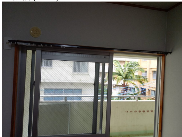
カーテンレール取付
