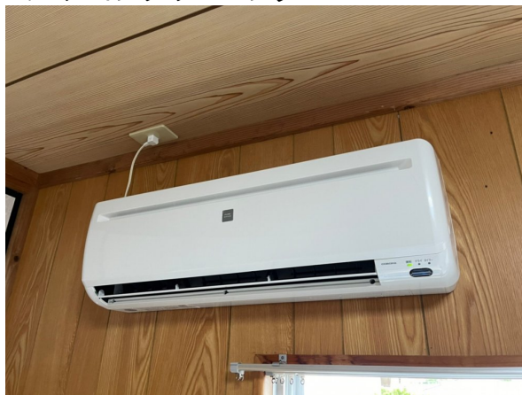
14.エアコンクリーニング
