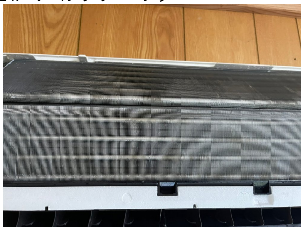
14.エアコンクリーニング
