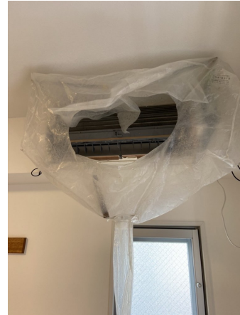
17.エアコンクリーニング
